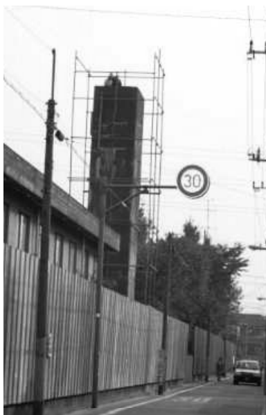
解体中の給水塔
